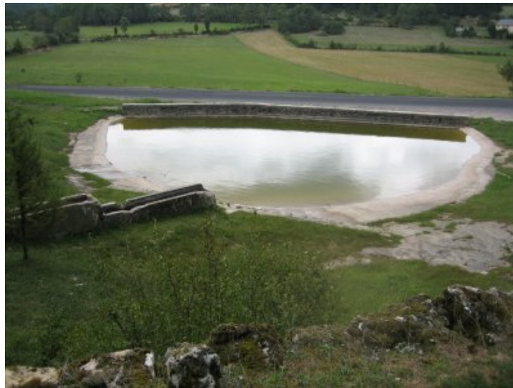
Retenue collinaire. Source : Wikipédia
